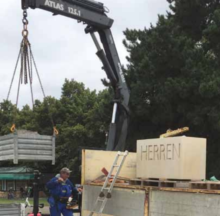
Der Schriftzug ist auf drei Blöcke verteilt, die einzeln gesetzt wurden.
